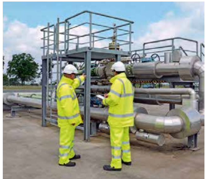
Betriebskontrolle am Ölkavernenkopf
