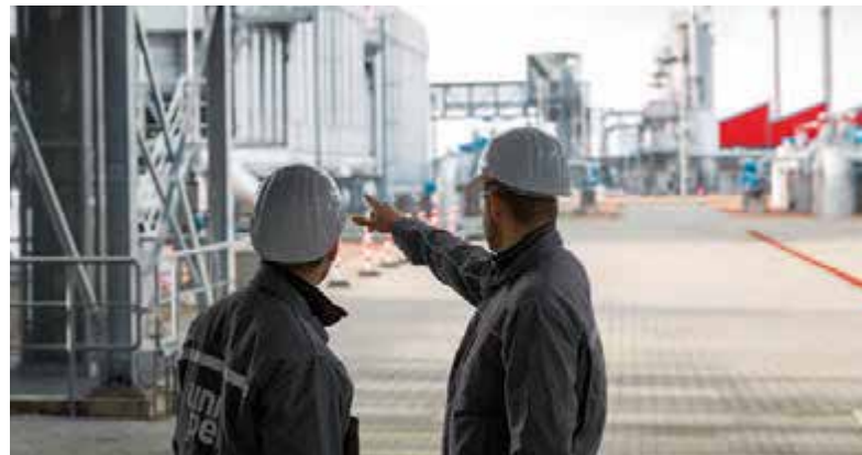
Blick auf Gaskühlung, Druckreduzierung, Trocknung und Kesselhaus
